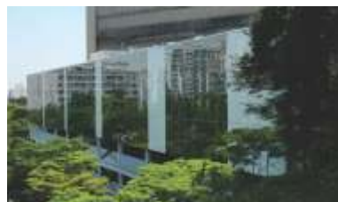
Vista Lateral - Av. Rebouças
