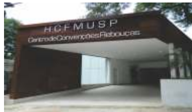
Fachada - Av. Dr. Enéas
